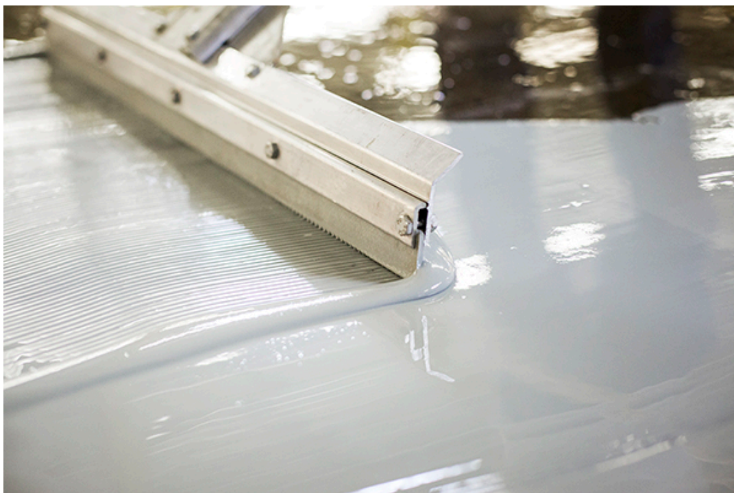
Foto: Aanbrengen vloeistofdichte beschermlaag.
