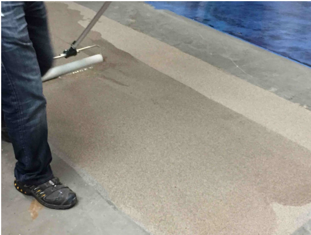
Foto: Aanbrengen primer.
